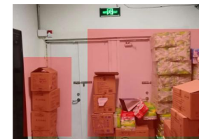
室内疏散通道占用
